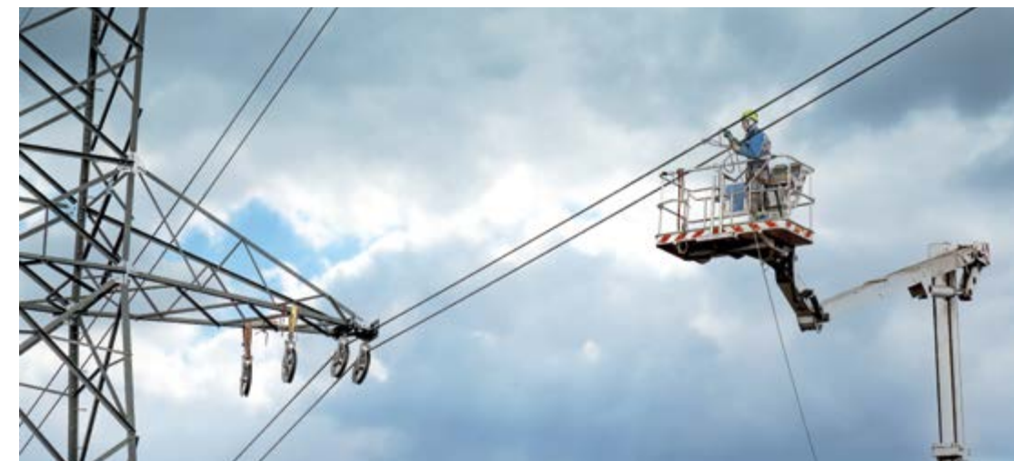
A 132, 220, 400 (képünkön) és hajdani 750 kV-os távvezetékeken is volt munkavégzés Fotó: MVM XPert | Réti Dóra
