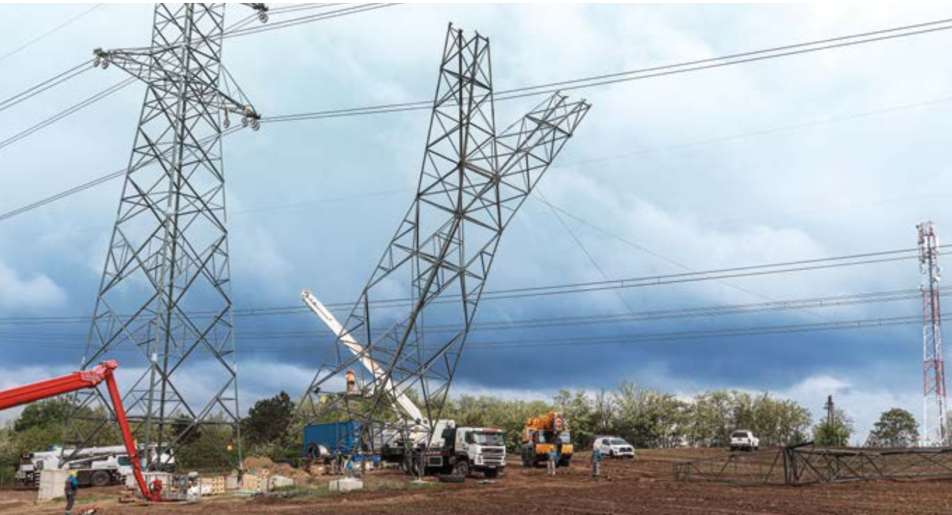
Régi oszlop kidöntése Ceglédbercelnél az Albertirsa – Szolnok 400 kV-os távvezetéken Fotó: MVM XPert | Réti Dóra
