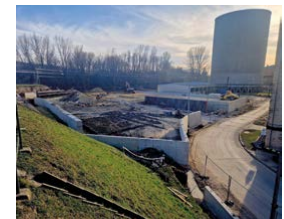
Megépített támfalak, részben feltöltött munkaterület Fotó: MVM Balance Zrt.
