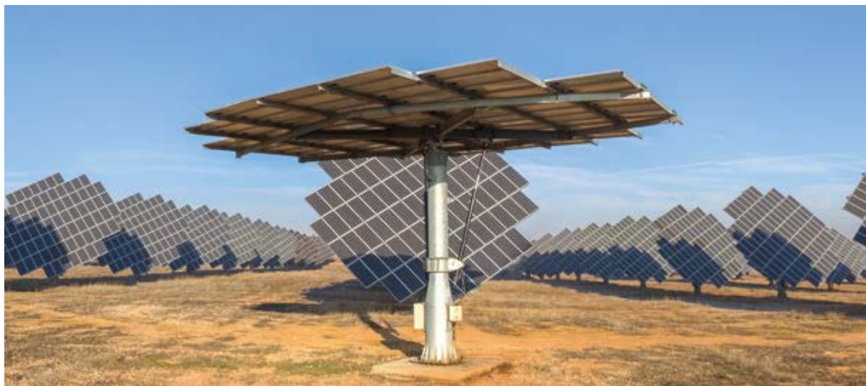
Kétirányban forgatós (két-tengelyes) tartószerkezet Fotó: Wikimedia Commons
