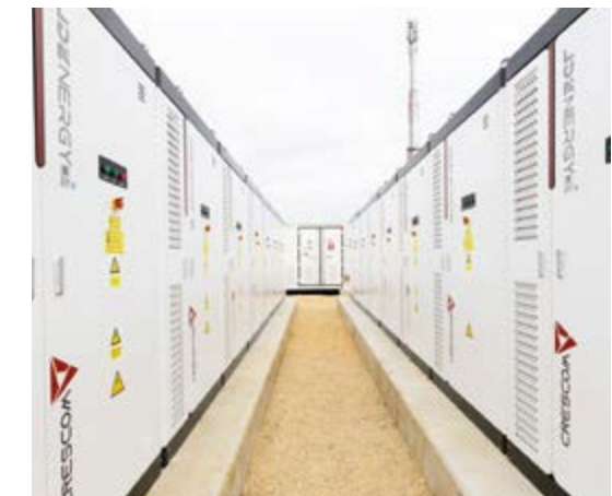
Az eBlock 418 energiatároló-egységek (egy része), háttérben az egyik 3,15 MVA teljesítményű lemezházás transzformátorral Fotó: MVM Csoport
