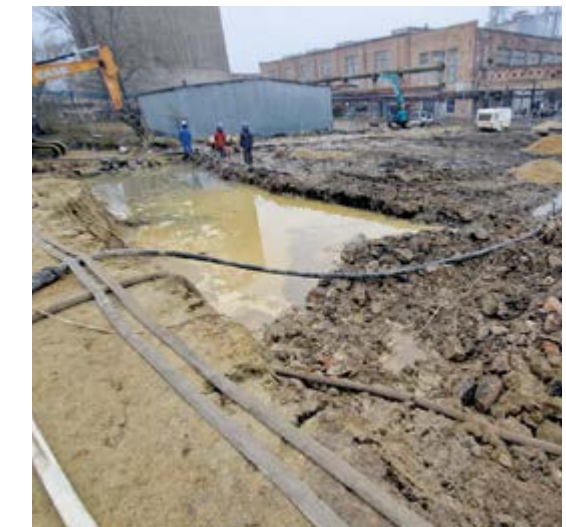
Vákuumos talajvízszüllyesztés a területen Fotó: MVM Balance Zrt.
