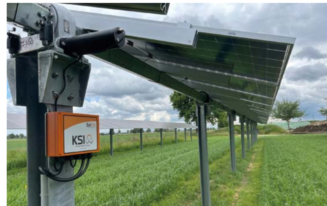
Egyirányban forgató (egytengetyes) tartószerkezet Fotó: KSI Solar
